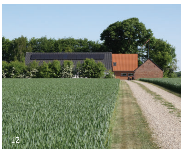
Foto 12: Eksempel på fint integrerede solceller. Både solceller og tag har en mørk farve. Solcellerne følger tagets længde og har en sluttet, rektangulær form.
