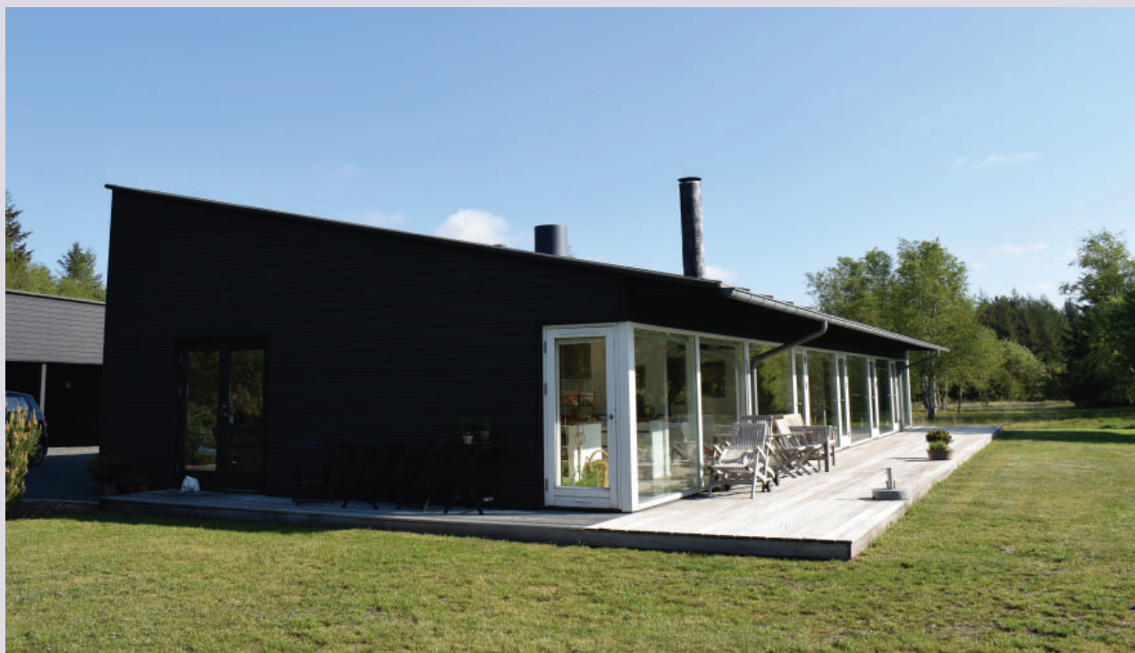
Eksempel på fint tilpasset bygning i landzone. Bygningen har en karakteristisk udformning med ensidig taghældning. Bygningen opfattes lukket fra gårdspladsen, men åbner sig op ud til haven med store glaspartier. Bygningens formsprog er gengivet i garagen overfor, og de to bygninger danner et let aflæseligt rumforløb med deres klare arkitektoniske form, der står i kontrast til den vilde natur lige uden for grunden.
