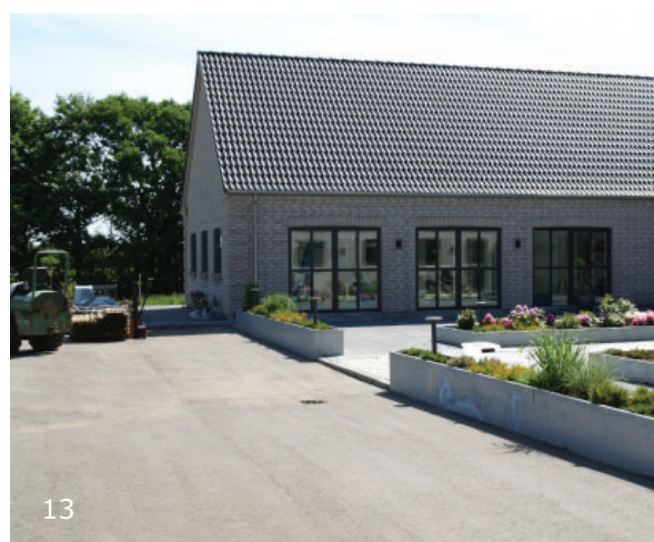
Foto 13: Eksempel på nybyggeri i landzone. Farveskalaen er holdt i de grå nuancer og bygningen har karakter af en 3-længet gård med et fint gårdhave anlæg i det omkransede gårdrum. Det er kun den ene længe, der kan ses på billedet. Bygningens arkitektoniske udformning er tydeligt inspireret af den klassiske byggeskik på landet med høj taghældning og fin detaljegråd i murværket, mens vinduerne er en mere moderne fortolkning.
